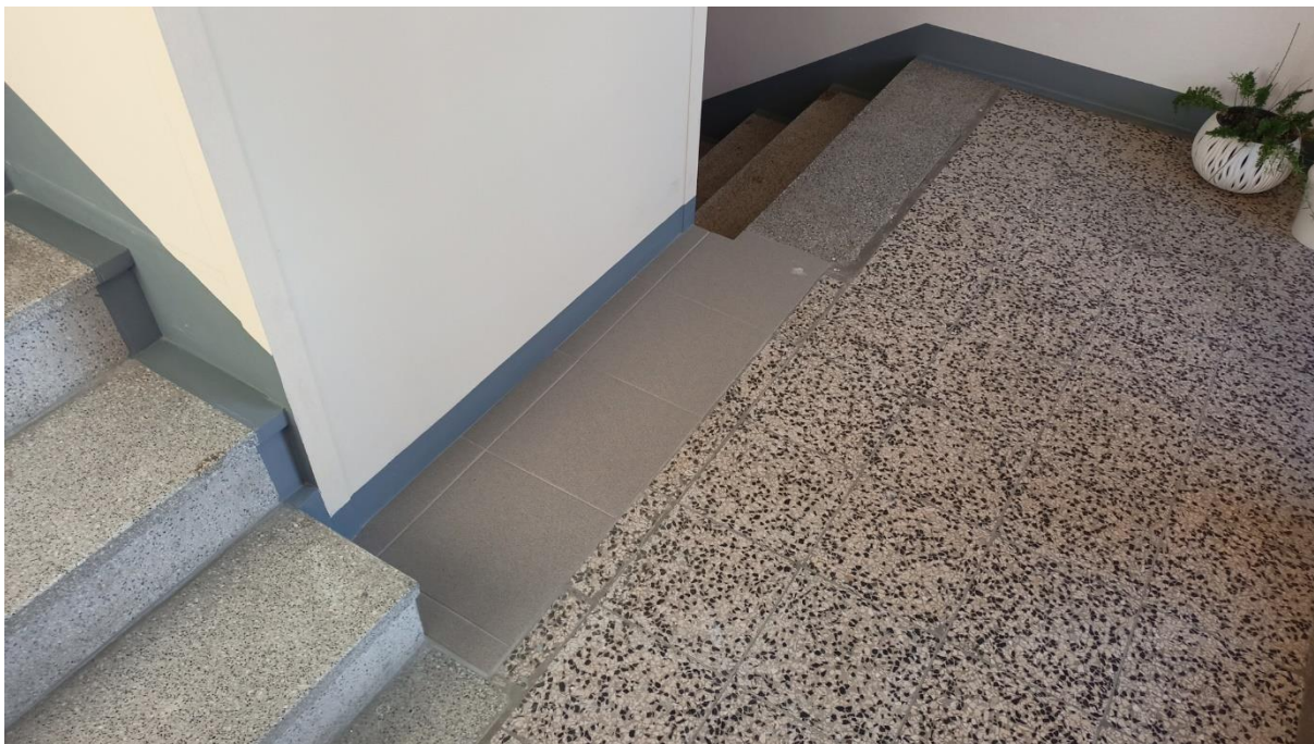
Detail provedení dopojení mezipodesty k výtahové šachtě
